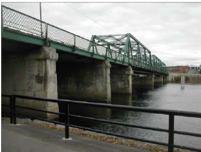
Pont Lady-Aberdeen... des travaux majeurs en cours
